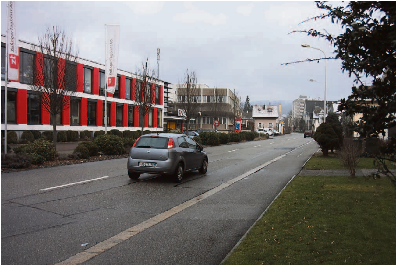
Die Zofinger Henzmannstrasse ist sanierungsbedürftig.
